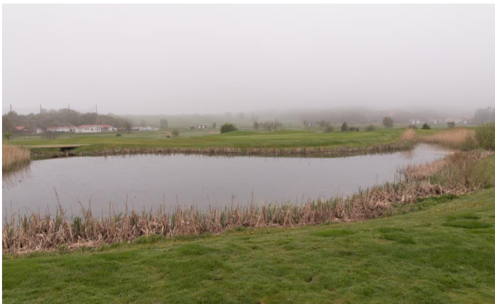
Figur 7. Damm 2, med utloppet mot damm 1 i den bortre södra delen av dammen.
